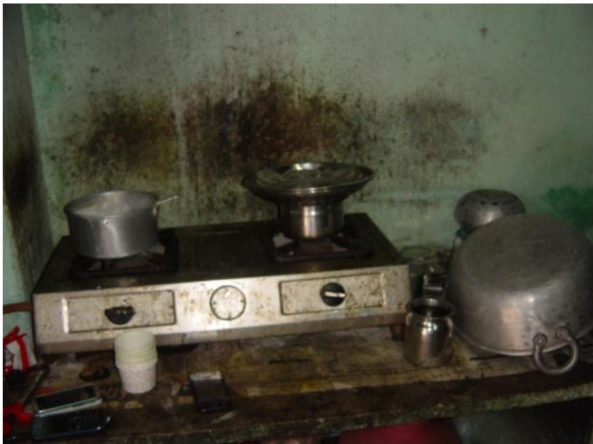
Abbildung 2: Einige Unterkünfte sind in desolatem Zustand.
