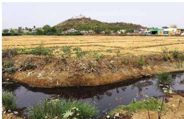
Der Gerbereiabwasserkanal verläuft durch Reisfelder in der Nähe Chrompets
